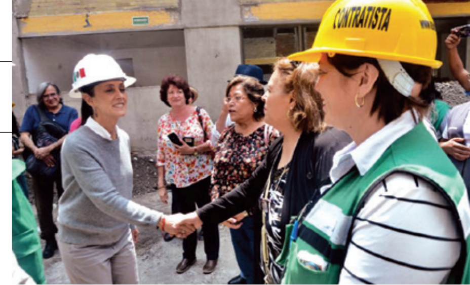
Claudia Sheinbaum, Jefa de Gobierno, y César Cravioto, comisionado de la Reconstrucción, realizaron un recorrido para supervisar el estado que guardan las obras de reconstrucción en el Multifamiliar Tlalpan.
