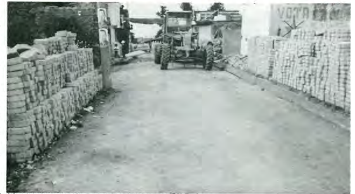
Adoquinamiento de calles, compromiso hecho realidad
