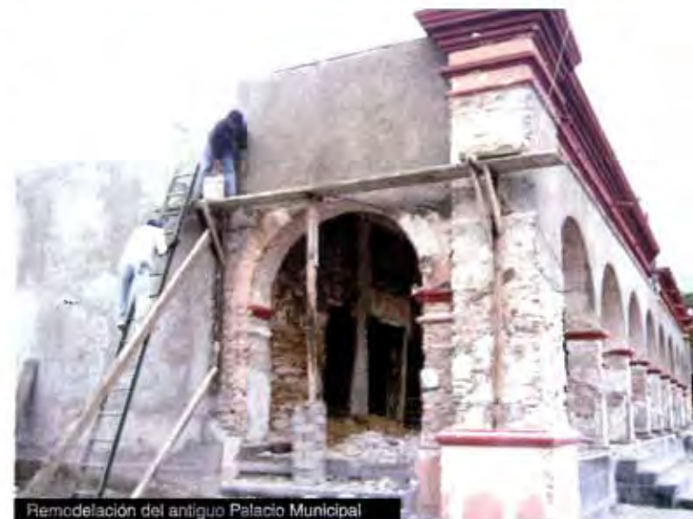
Remodelación del antiguo Palacio Municipal
