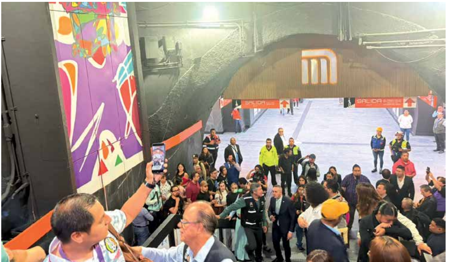
La Línea 7, que va de Barranca del Muerto a El Rosario, es una de las más profundas y tiene filtraciones permanentes; sus escaleras eléctricas no funcionan pese a que en fecha reciente fueron reinauguradas por la Jefa de Gobierno.
