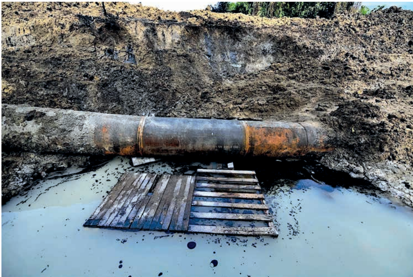
Inundaciones en la zona norte provocaron la fractura de un ducto y, con éste, millones de crudo vertidos al río Pantepec.
