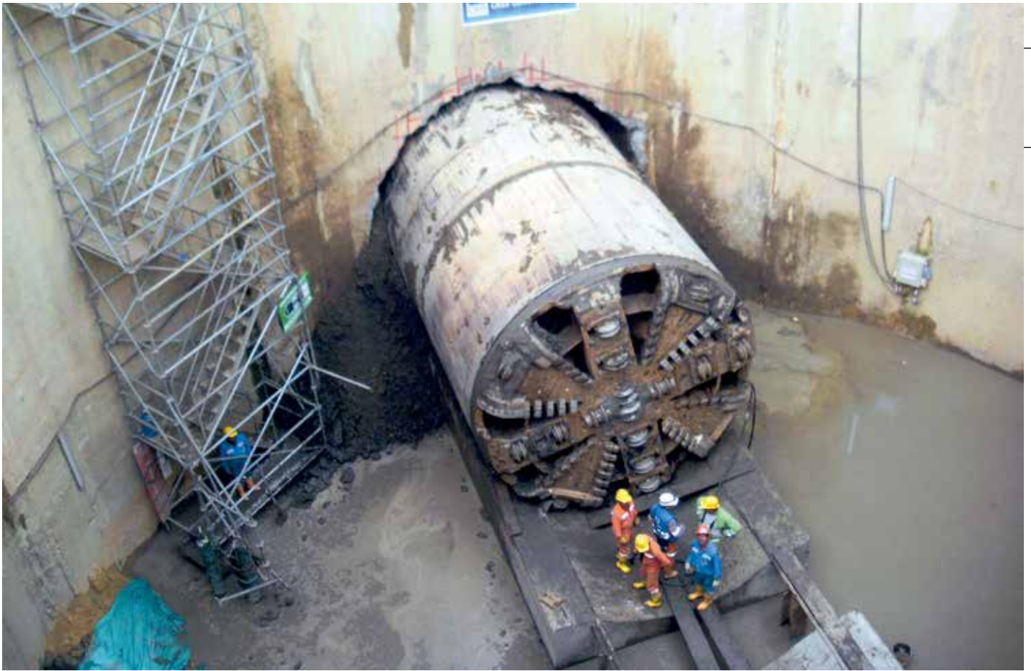
En 1867, las autoridades federales iniciaron la construcción del Gran Canal de Desagüe, que empezó a funcionar hasta 1900; en 1962 pusieron en servicio el Túnel Emisor Poniente y en 1975 el Túnel Emisor Central.
