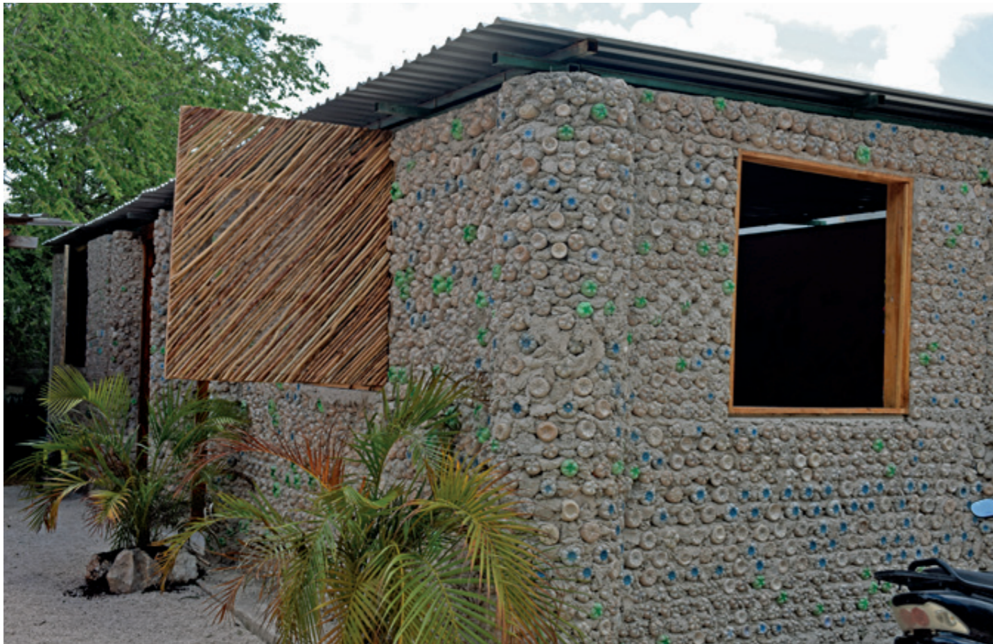
Mientras el gobierno estatal no toma medidas contra la contaminación, los habitantes del ejido de Macario Gómez se unieron a la ONU en un proyecto que implica la construcción de aulas con botellas de plástico como tabiques.
