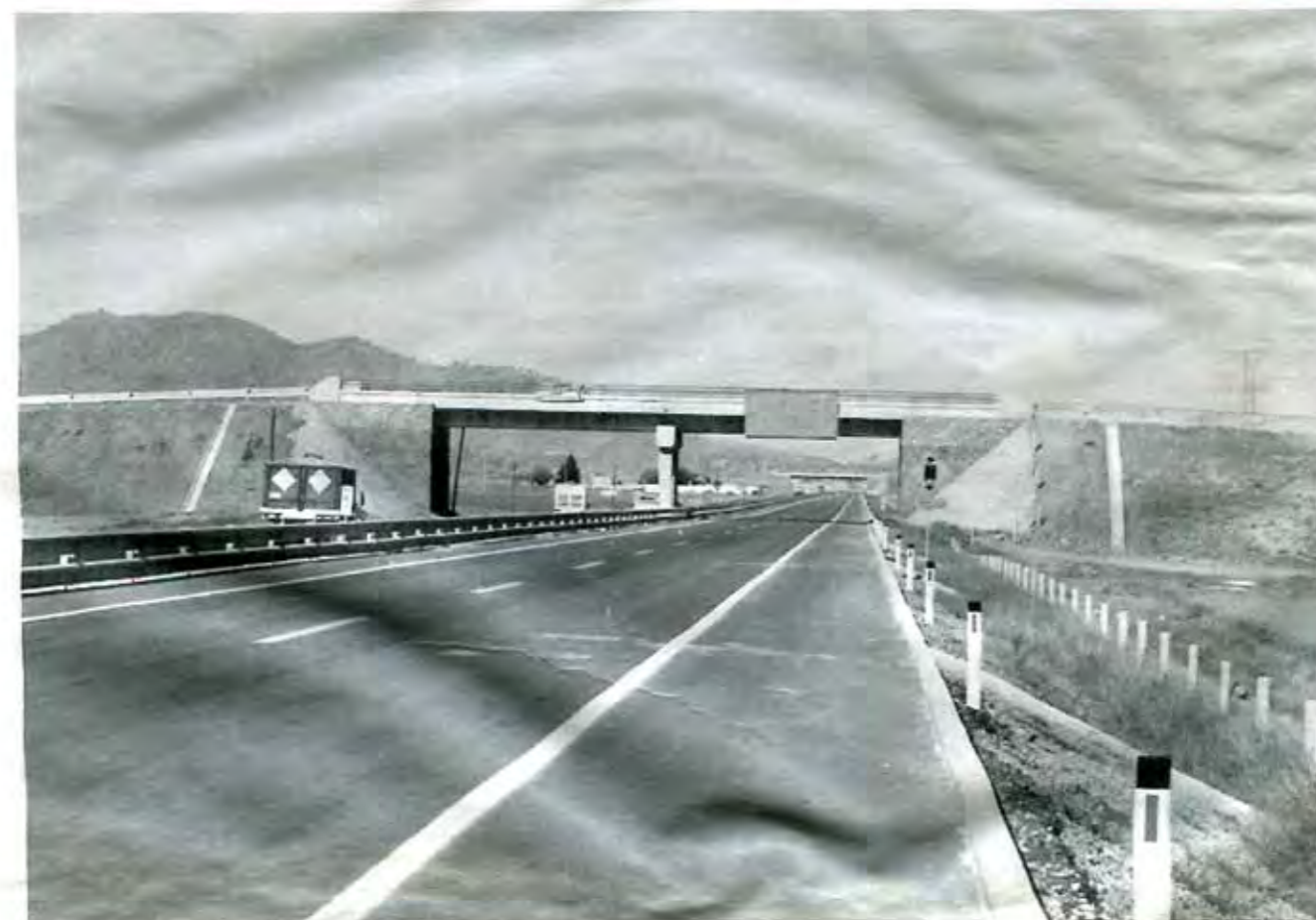
Concluido el primer tramo de la Autopista a Tezcuhtlán.
