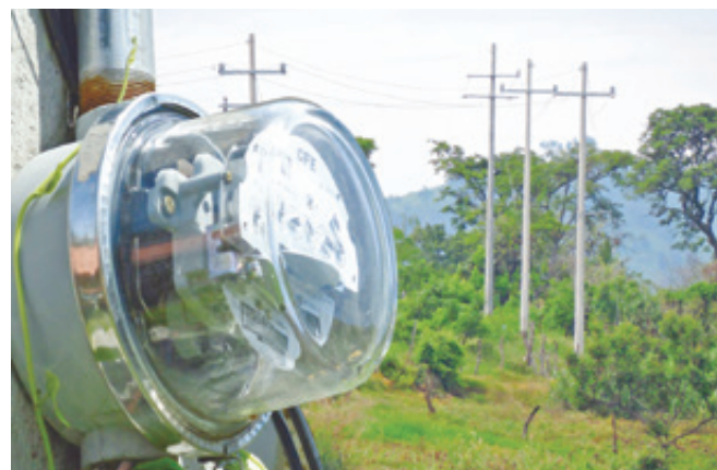
Ampliación eléctrica, San Pedro Hueyahualco.
