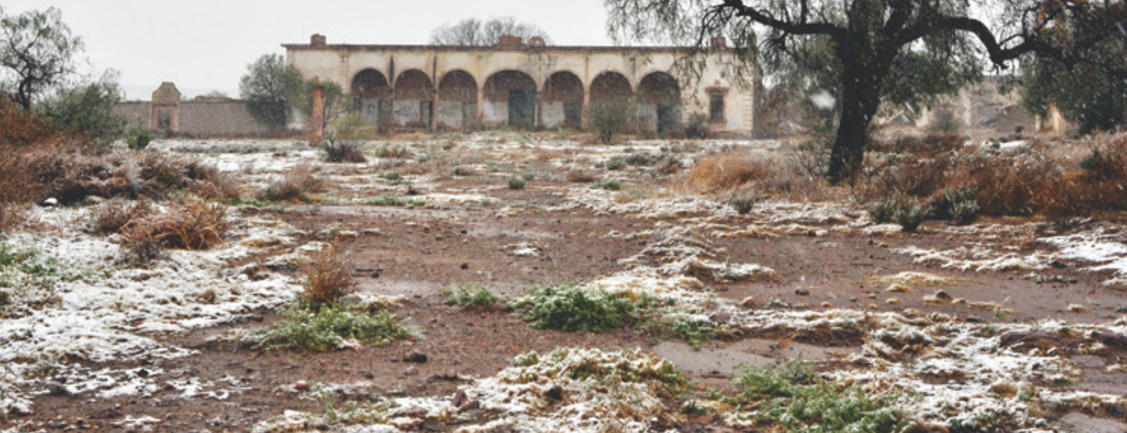
Ruinas exhacienda San Francisco.
