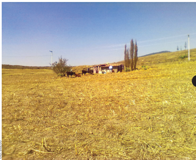
La casa de doña Catalina, hecha de piedras y láminas de cartón, además de no tener los servicios básicos, está prácticamente cayéndose y no tiene posibilidades de repararla.
