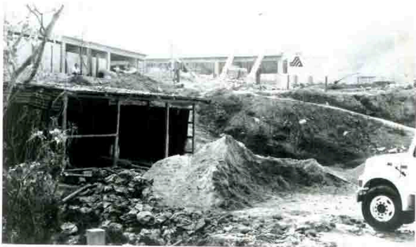
CONSTRUCCIÓN DE UN HOSPITAL GENERAL.
