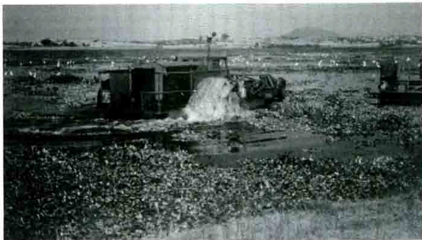
DESDE HACE 2 AÑOS NO SE LIMPIABAN LAS AGUAS DE LA PRESA
