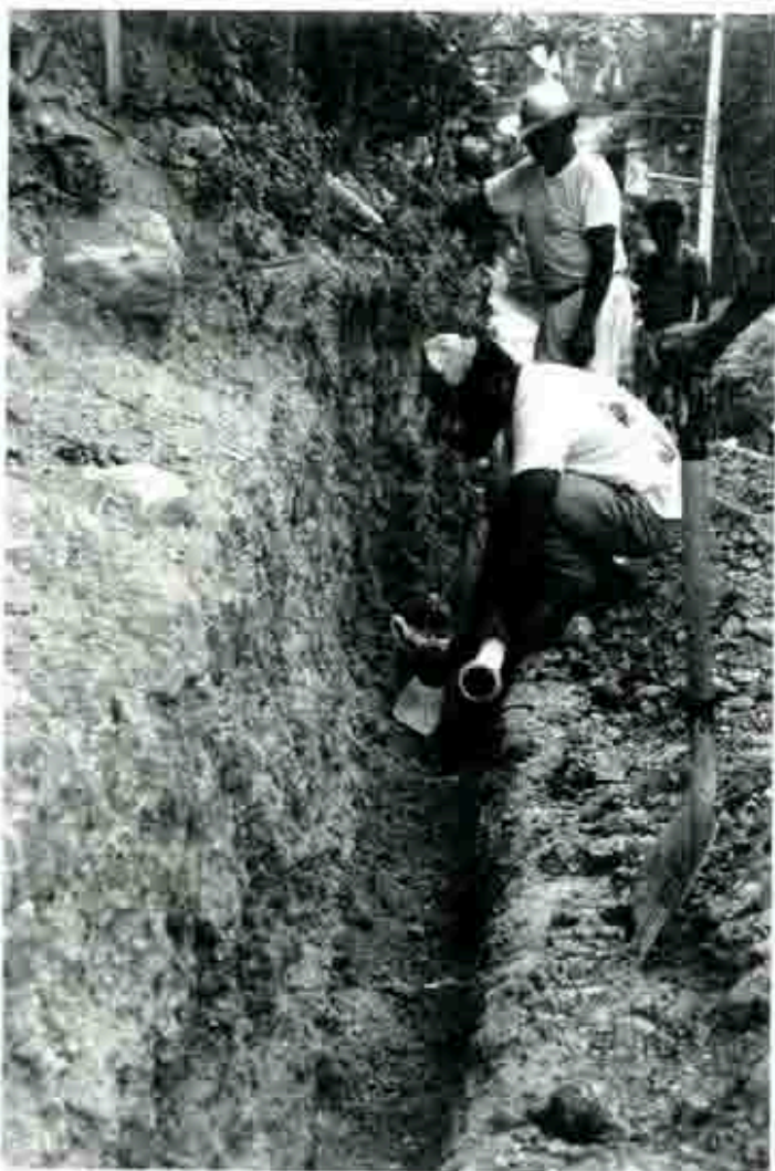
ENTERRANDO LA TUBERÍA DEL AGUA POTABLE QUE, PREVIAMENTE, HIZO SACAR EL ALCALDE
