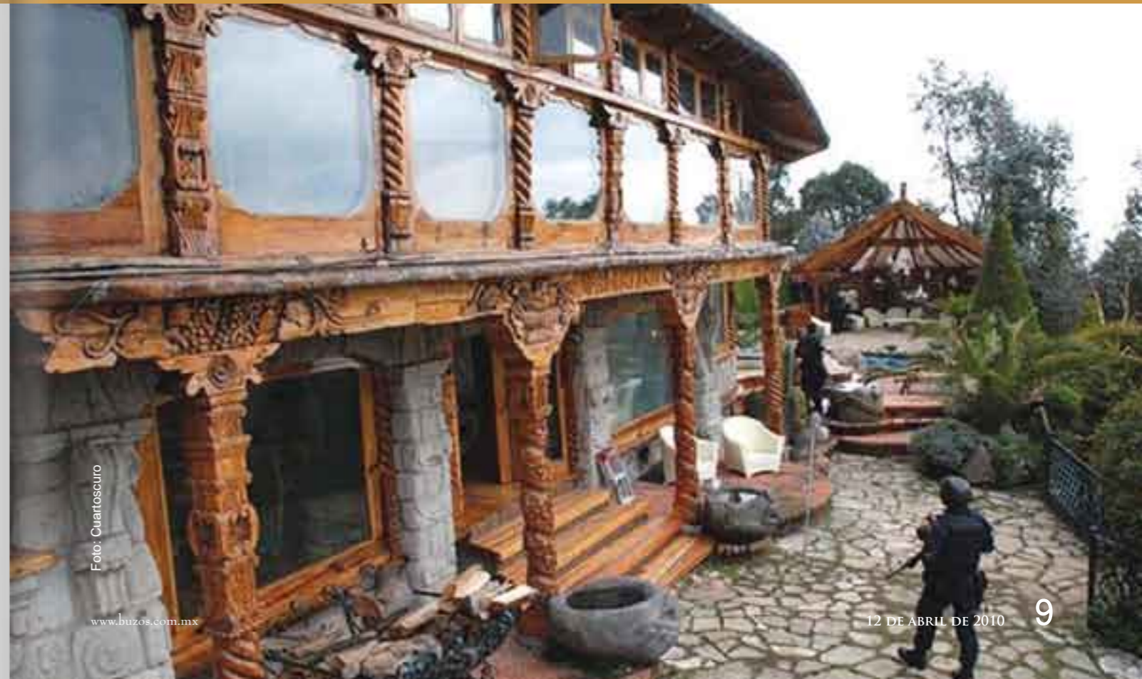
Incertidumbre sobre el destino final de los bienes inmuebles enajenados.
