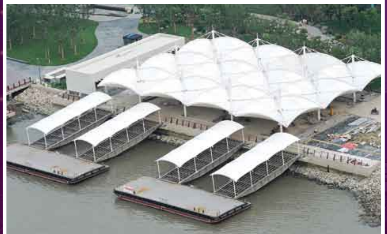
Muelle en construcción para la Expo Universal, en la metrópoli oriental de China.
