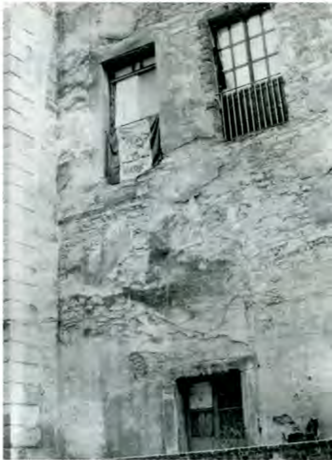
A 2 meses de iniciar el coloquio, las obras acumulan un rezago Foto: Carrasco Lira
