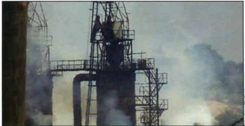
Pemex y termoeléctrica: 85 por ciento de la contaminación.
