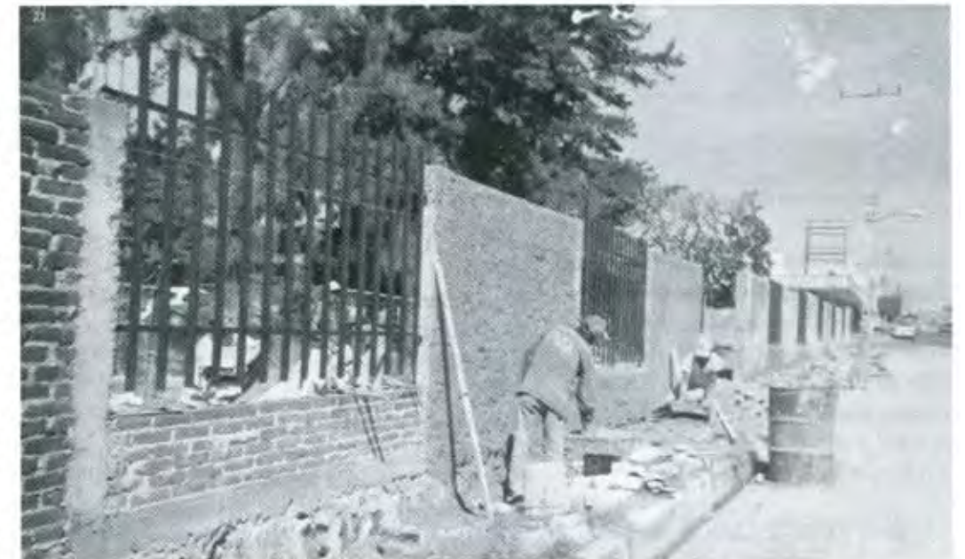
CONSTRUCCIÓN DE LA BARDA PERIMETRAL DE LA TÉCNICA 3
