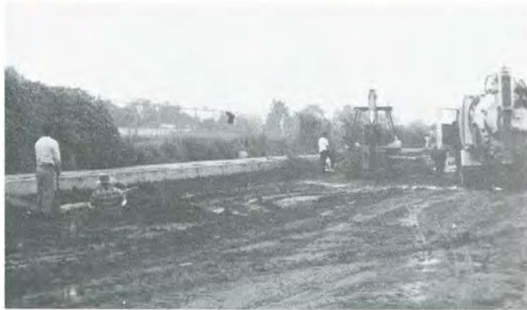
DE INMEDIATO REINICIARON LAS OBRAS
