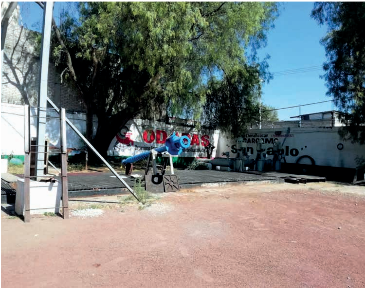
Antes, el cárcamo San Pablo contaba con tres motores operando; ahora, con el retiro de dos, trabaja al 30 por ciento de su capacidad, lo cual está ocasionando que se inunden las casas en los barrios San Pablo y San Pedro.
