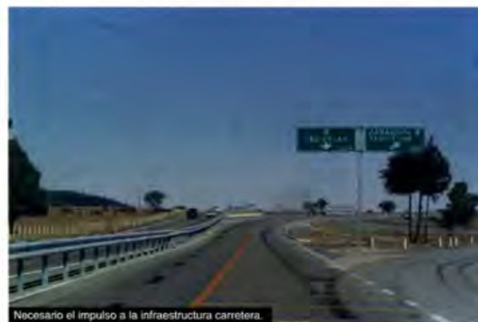
Necesario el impulso a la infraestructura carretera.
