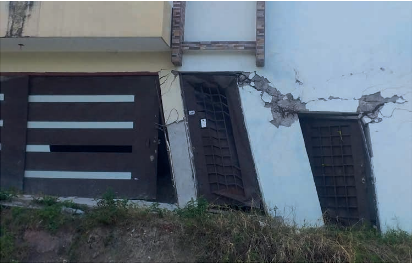
En Villas Tlalmecac y fraccionamiento La Era etapas I y II –de reciente construcción, cuyas viviendas prefabricadas se levantaron con placas de concreto pretensado– se encontraba (ya fue demolido) un edificio de cinco niveles y algunos departamentos muy agrietados y en grave peligro de desplome debido a una falla de la ladera.
