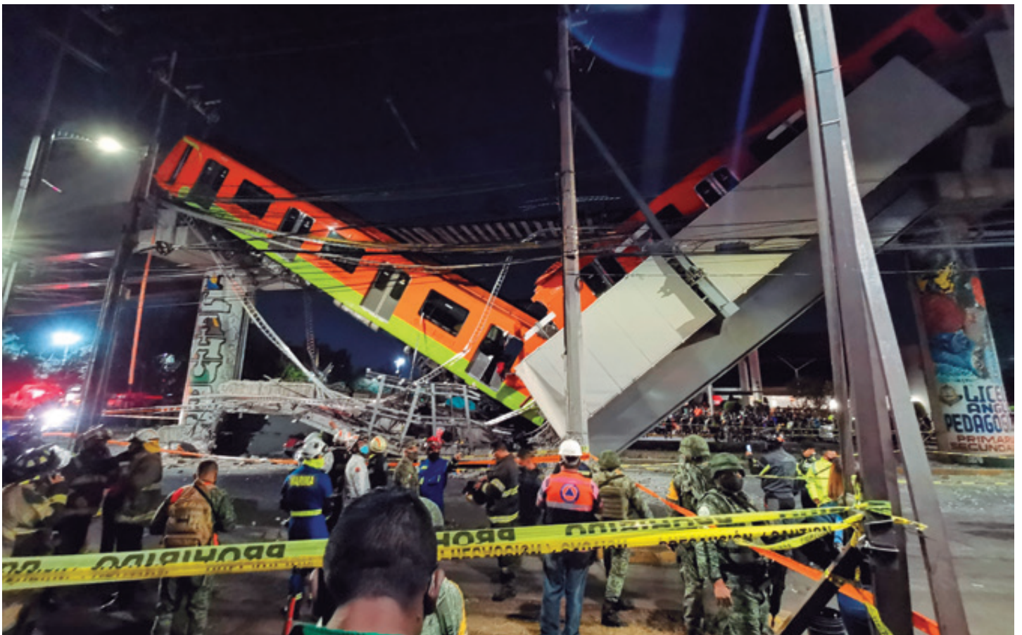
La noche del tres de mayo fallecieron 26 personas y 79 más resultaron heridas cuando una trabe de la Línea 12 del Metro colapsó.
