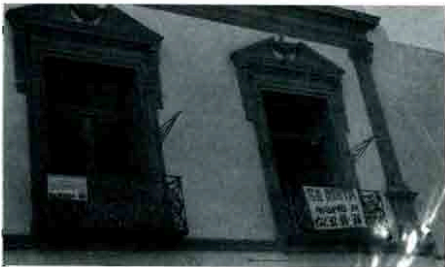
LA FUNCIÓN DEL INAH ES EVITAR QUE SE ALTEREN LAS CONSTRUCCIONES / COL + NI LES
